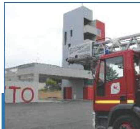
1,9 million € pour le centre des pompiers
